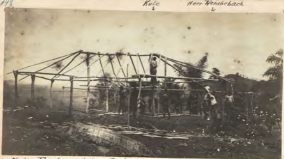
Meine Forschungsstation Bafiahöhe (mein Wohnhaus) im Bau
