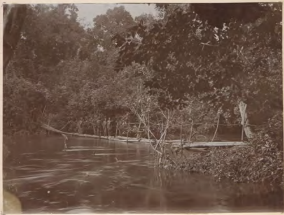
Brücke über den Bimfite bei Biänemayong (unterhalb meines Badeplatzes)
